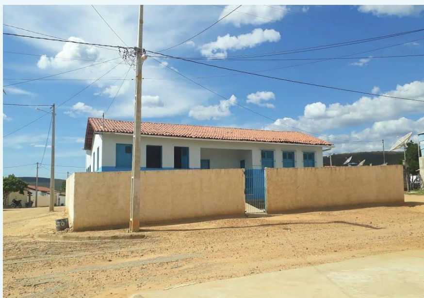
Figura 1: Prédio da Extensão do CERV no Povoado do Capinado, Anagé/BA
