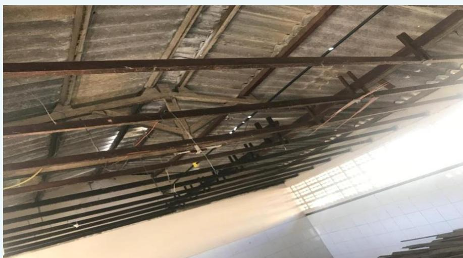
**Figura 1: Sala de aula interditada após o teto apresentar riscos de desabamento.**
