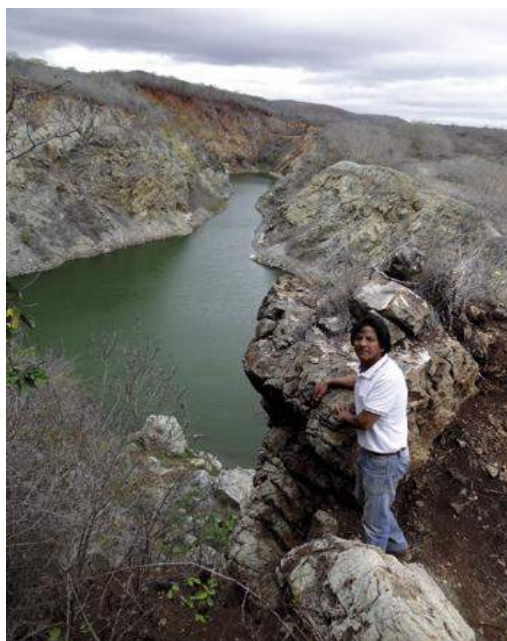
Figura 02: Cava atingiu o lençol freático e comporta água contaminada.
