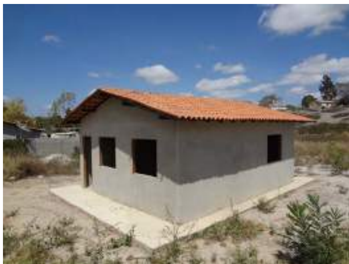
Figura 1 – Casa em construção na vila de Dantelândia, município de Vitória da Conquista, Bahia, 2017.
