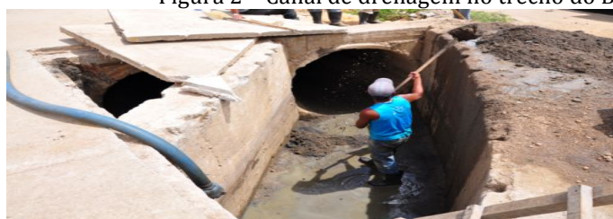
Figura 2 – Canal de drenagem no trecho do Bairro NSA
