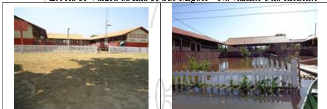
Escola de Várzea da Ilha de São Miguel – Na vazante e na enchente
