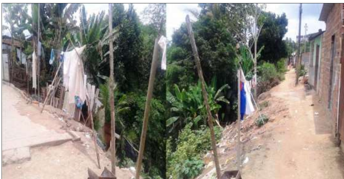
Figura 2 – Aspecto de áreas de construção de moradia do Bairro Renato Machado, 2016
