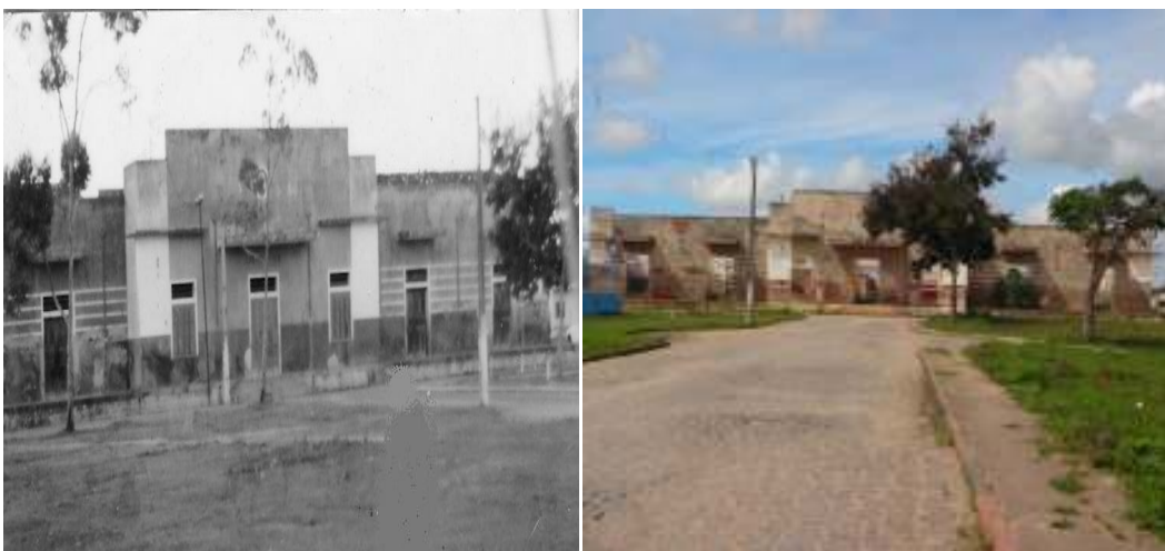
Figura 3: Estação Ferroviária de Castro Alves, 1990 e 2013. Fonte: Acervo dos autores, 2014.
