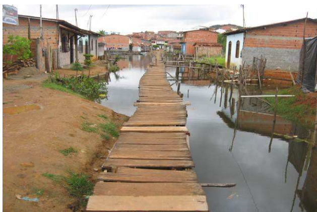
Figura 4-Ponte sobre área de manguezal invadida
