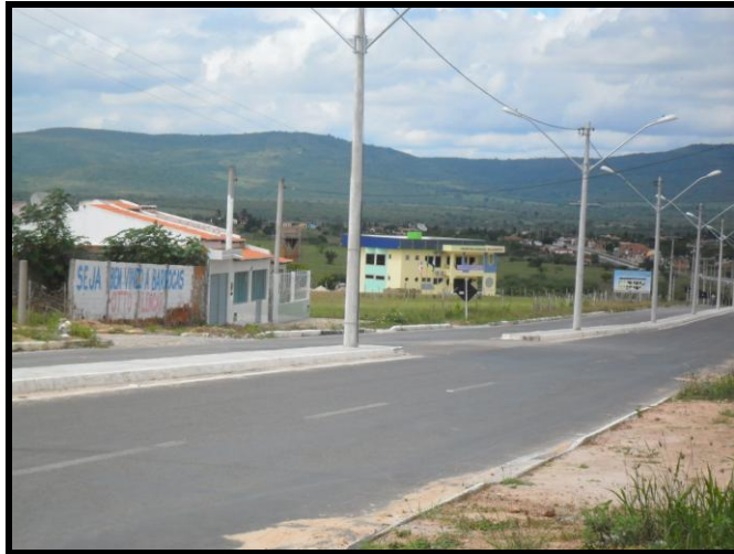
Figura 05. Sede própria da Prefeitura de Barrocas na Avenida ACM.
